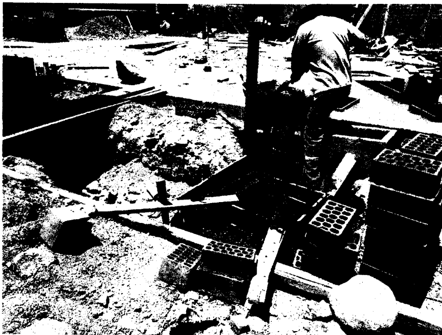
Vaciado de concreto en buzones de concreto
