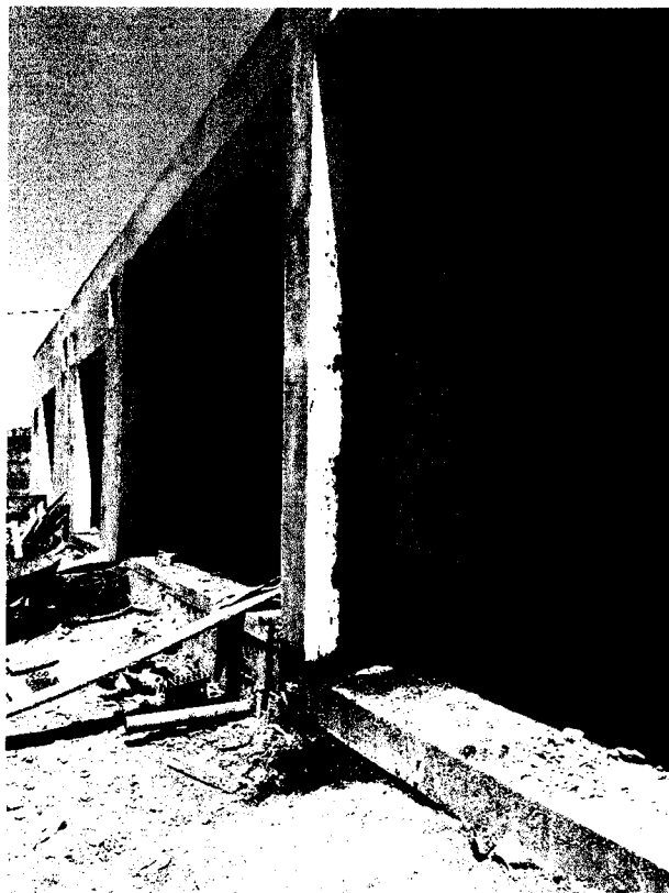
Concreto en falsa columna de 0.1x0.1x3
