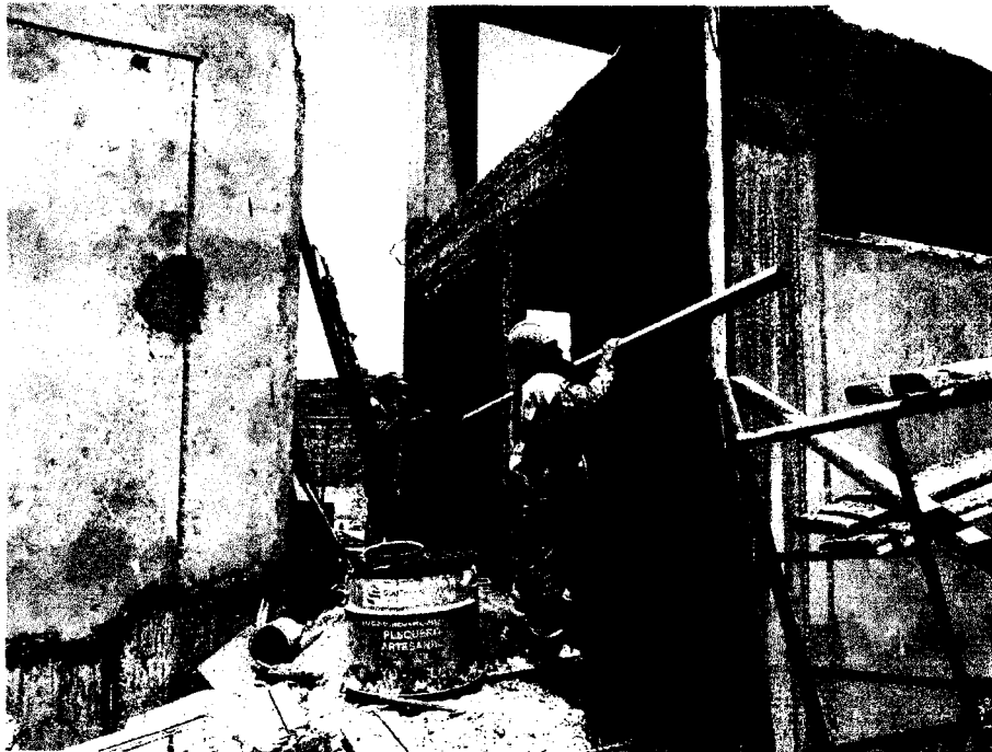
Tarrajeo en muros exteriores de la caseta de bombas del tanque elevado
