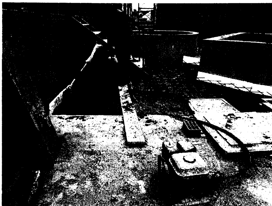
Vaciado de concreto f'c=280 kg/cm 2 en losas del patio de maniobras
