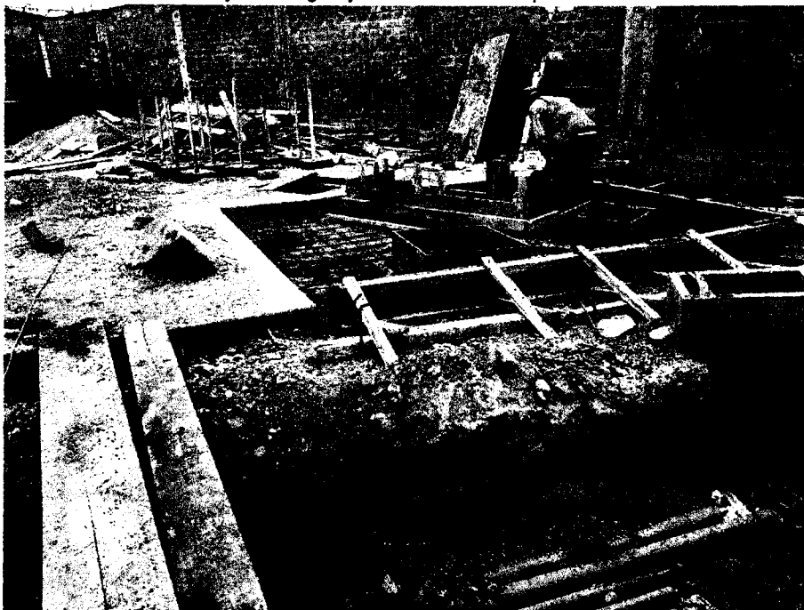
Encofrado, habilitación de acero en losas del patio de maniobras.
